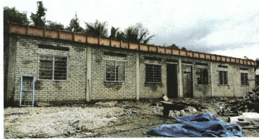
Rumah baharu untuk mangsa yang kehilangan rumah akibat banjir puing pada 4 Julai tahun lalu di Desa KEDA Kampung Sadek, Baling sedang dibina kontraktor yang dilantik kerajaan negeri. (Foto ihsan pembaca)
